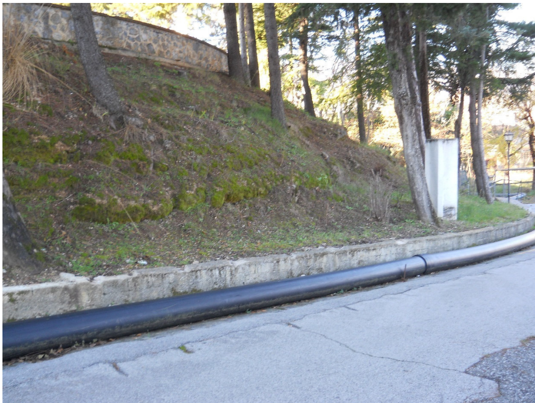
Foto 7 - Condotta di derivazione posta nella cunetta lato monte della strada nei pressi del ciglio di frana
